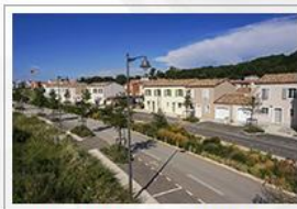
Une maison individuelle > 300 tonnes
