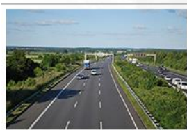
Un kilomètre d'autoroute > 30 000 tonnes
